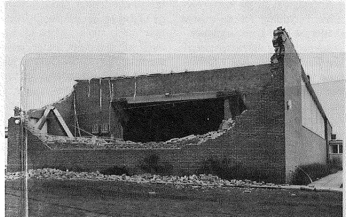
Figur 10. Gymnastiksal med scenerum, 470 mm hule mure med helstensbagvæg og pæptag med ringe hældning. Vind på langs af bygningen afrev først ca. 150 m 2 af taget nærmest gavlen, hvorefter dette ca. 90 m 2 store murfelt blev blæst ind. Taget var forankret med bolte 0,5 m ned i de omgivende mure. Gavlmuren var ikke forstærket med særskilte afstivende konstruktioner og mistede en understøttelseslinje, da taget var blæst af. (Foto: Tage Jensen).
